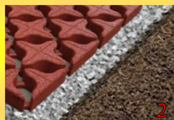
2 Tvárnice pokladáme na vrstvu štrkodrtie frakcia cca 0-16 mm
