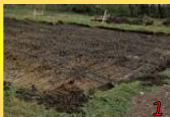
1 Odstrániť pôvodný trávnatý porast s ornícou cca 10-15cm
