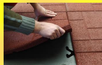
Aplikácie pomocou spodnej krížovej spojky.
