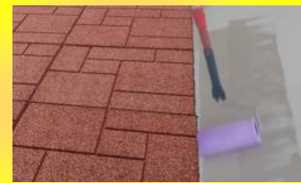
Aplikácia lepením, nanášanie lepidla na betónovú plochu
