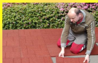
Pokládka na spevnený povrch, alebo betónovú plochu.
